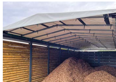
Entrepôt de copeaux de bois
