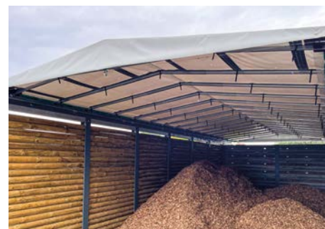
Deposito di minuzzoli
